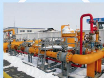
鑫泰米泉调配站 型号：JRZ-36000/1.6E22-M3
