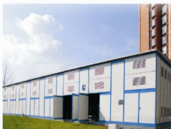
成都城燃赖家坡门站 型号：RX250000/1.6E-M6
