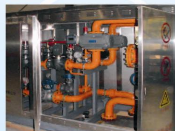
剑南春酒厂中中压调压箱 型号：RX2500/0.4C-M2
