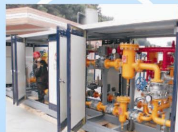
贵州龙里县中铁生态城气站 型号：RX2000+800/0.8CM
