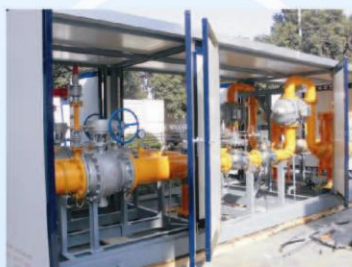
中石油四川天新中中压调压箱 型号：RX5700/0.8CM
